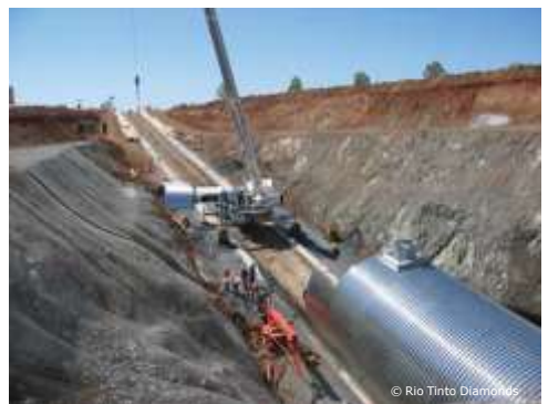
Die 2005 errichtete Rampe
