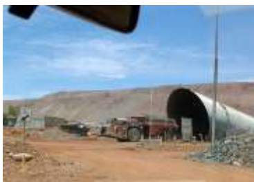
Accès au niveau d'exploitation souterraine
