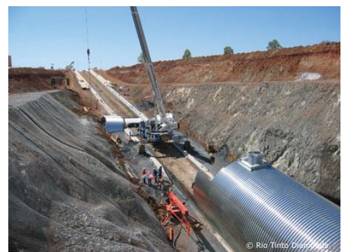
Die 2005 errichtete Rampe
