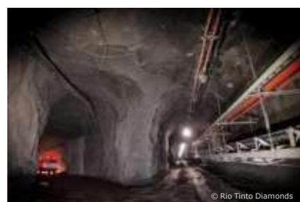
Pour l'aménagement de la mine souterraine, un réseau de tunnels d'une longueur totale de 40 kilomètres a été construit. Les accès principaux du réseau souterrain des voies forment quatre tunnels : deux sont dédiés au transport des véhicules, un à la ventilation et un autre à l'acheminement du minerai. Au total, 273 points de tirage ont été disposés. Leurs chargeuses embarquent le minerai via 16 tunnels de production.
